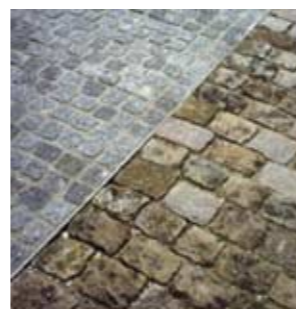
markeringer i en belægning
